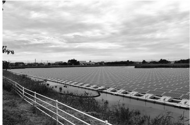
（阿部池に浮かぶ出力約 8.9MW のメガソーラー）
