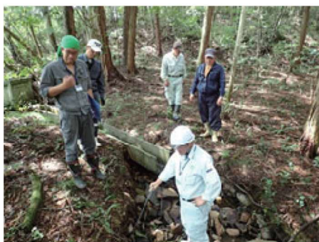
漏水状況確認
