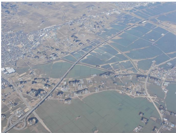
津波浸水状況（名取市付近）
