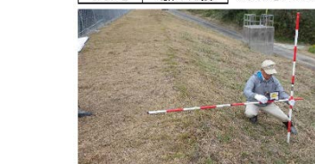
No. 2 堤体の下流側
